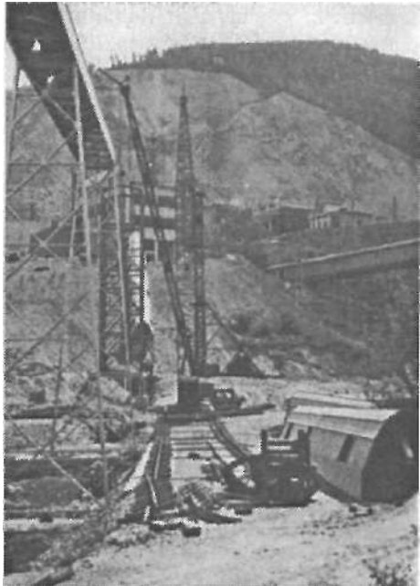
Výstavba dopravníka suroviny z lomu do cementárne
