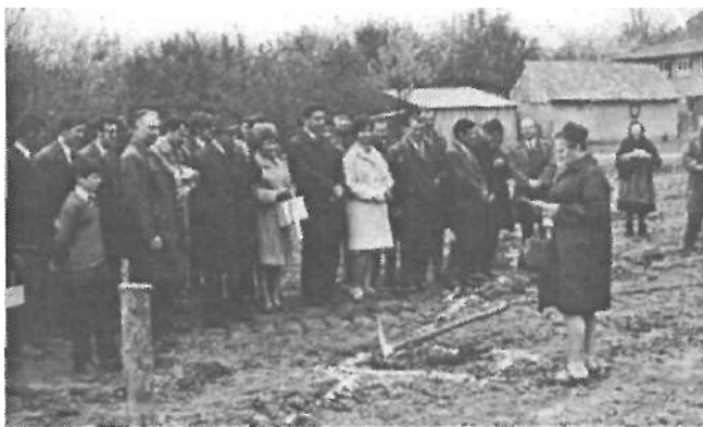
Slávnostný výkop na novej ZDŠ 7 mája 1971
