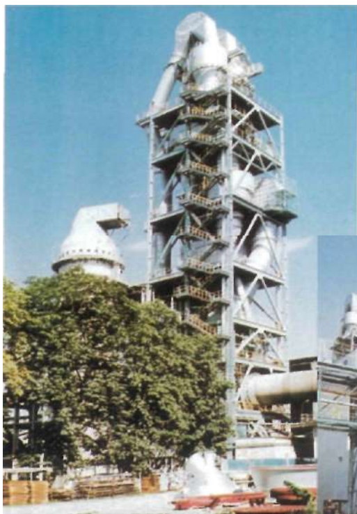
Časť výrobných zariadení v cementárni.
