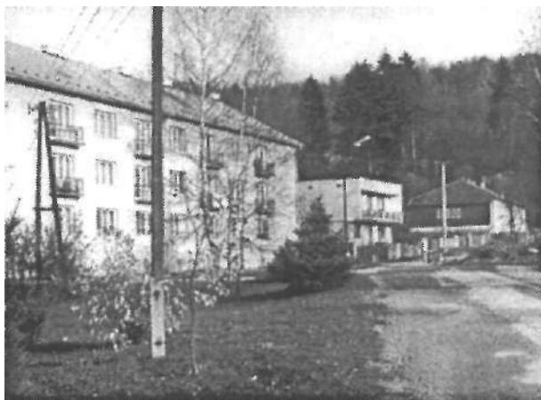
Bytová výstavba v Horných Ladcoch
