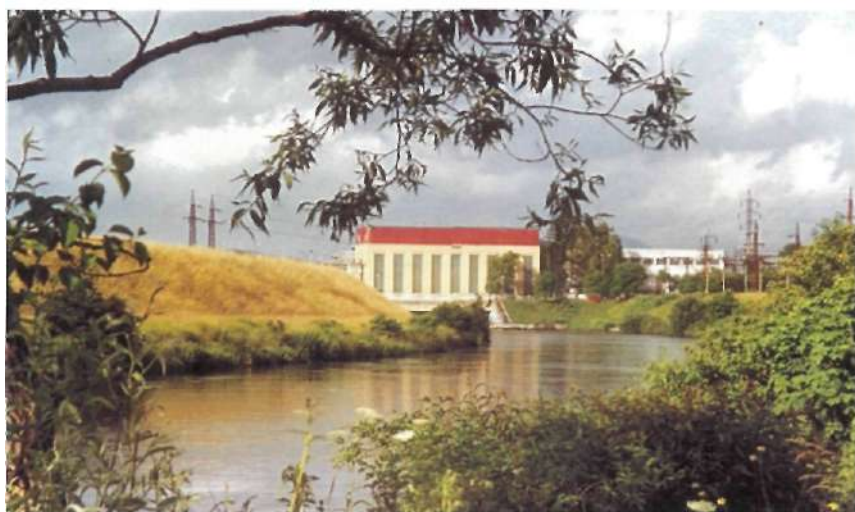
Najstaršia veľká vodná elektrárňa na Slovensku v Ladcoch postavená v rokoch 1932-1936.
